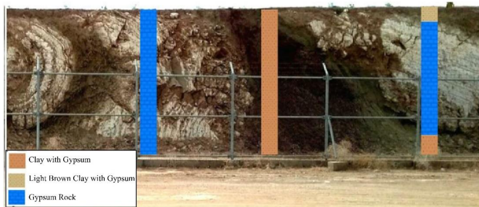
شکل ۹. لایه‌بندی پیچیده به همراه جنس متنوع مصالح در ترانشه مجاور سایت پتروشیمی مسجدسلیمان Fig 9. The trench near the Masjed Soleyman petrochemical site with features complex layering and varied lithology.
